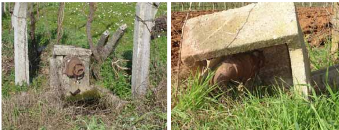
Figura 8 e 9 – Pormenor das bocas de saída do sistema de regadio – Travassô.
