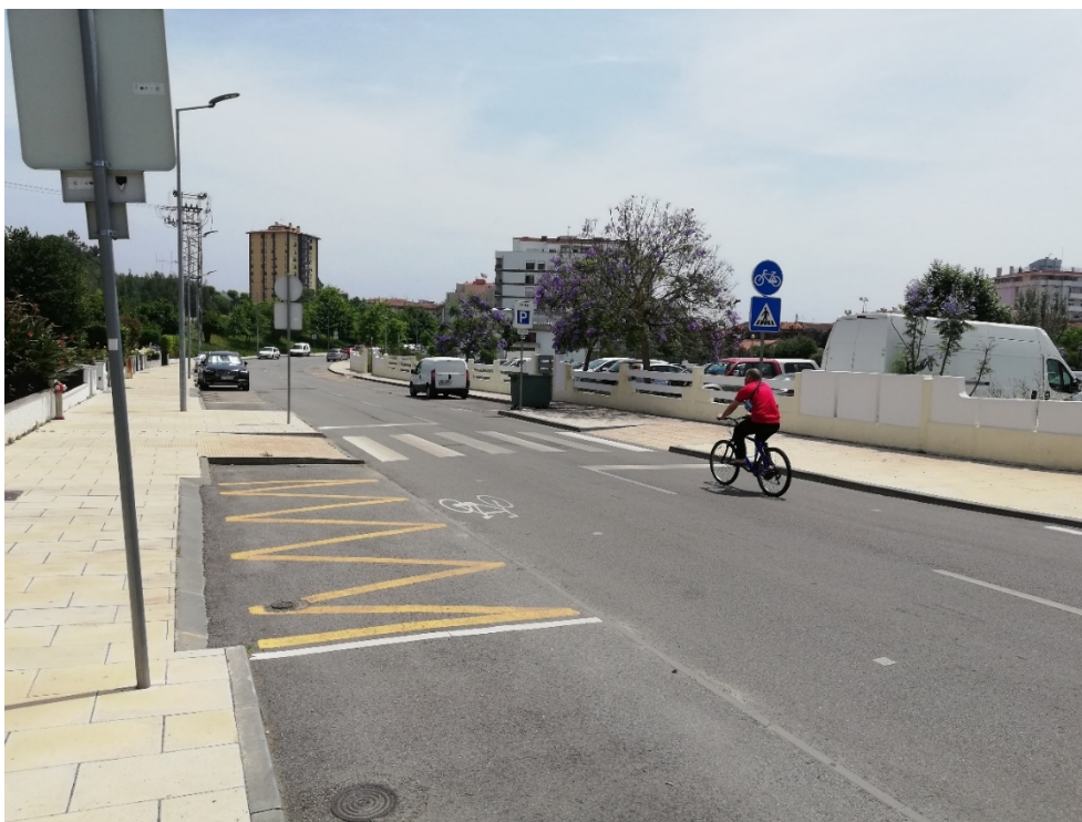
Fig. 75 Exemplo de via partilhada na Rua Eng. José Bastos Xavier
