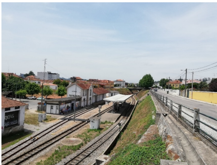
Fig. 85 Estação ferroviária de Águeda
