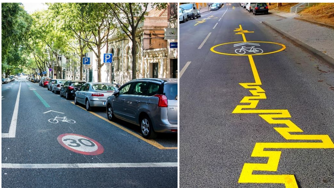
Fig. 54 Bom exemplo (à esquerda) e mau exemplo (à direita) de implementação de via ciclável partilhada
