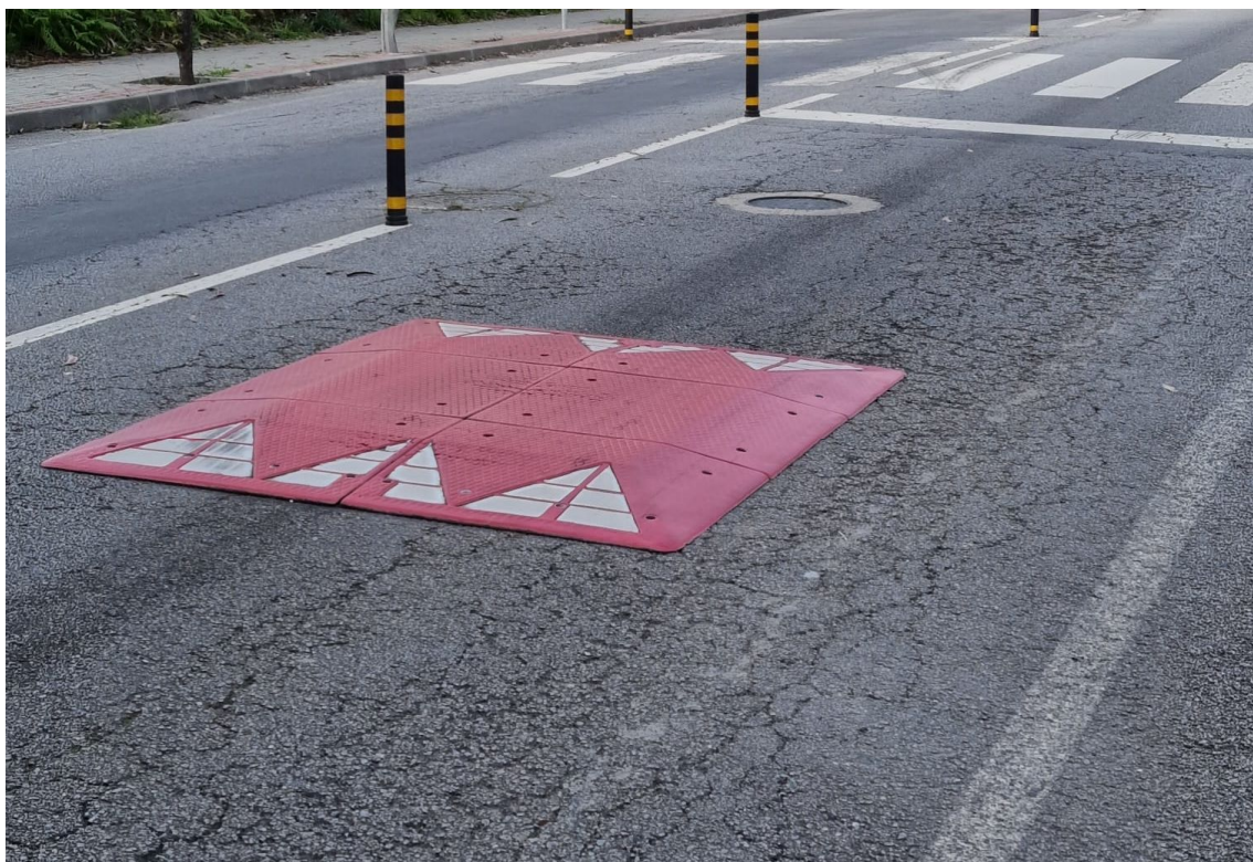
Fig. 20 Exemplo de almofada redutora de velocidade
