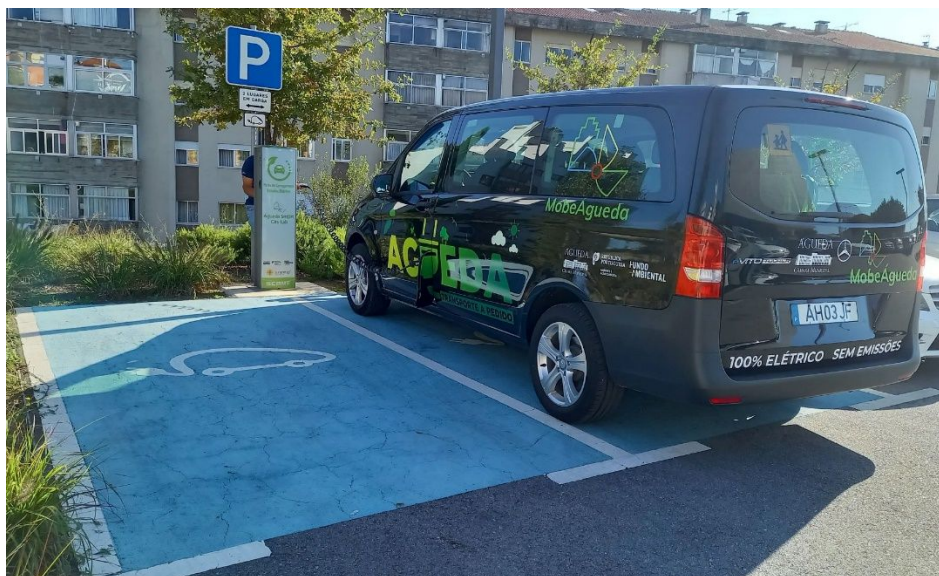
Fig. 76 Posto de carregamento elétrico no estacionamento do Centro de Artes de Águeda
