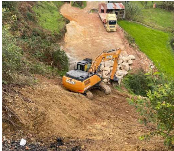
Obras de reforço e reabilitação do talude na Rua do Vale de Erva, junto à linha de caminho de ferro
