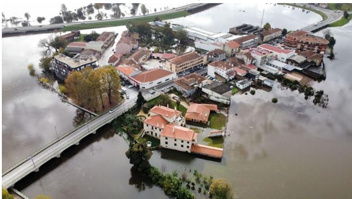
Figura 140: Inundação em Águeda (2022) 68
