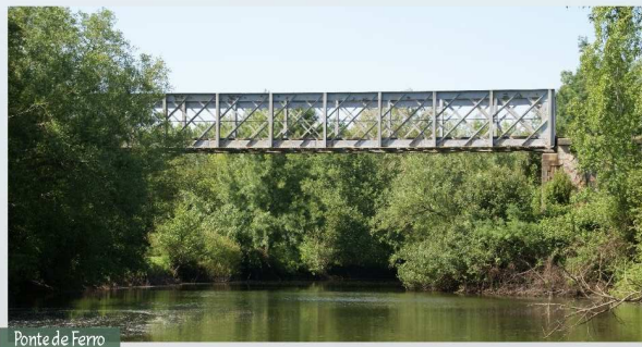
Ponte de Ferro
