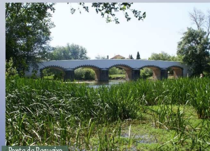
Ponte de Requeixo
