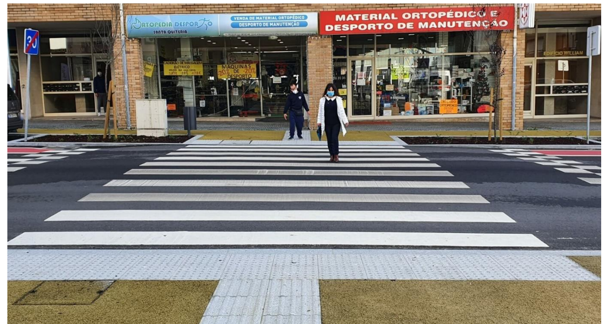
Figura 46. Exemplo de solução específica para rebaixamentos-tipo 3 em Felgueiras
