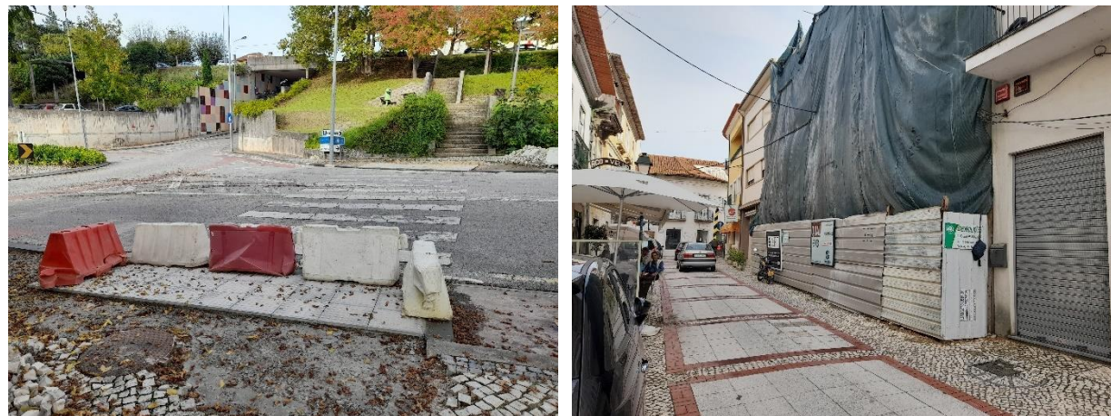
Figura 37. Exemplo de obras a obstruir o percurso pedonal
