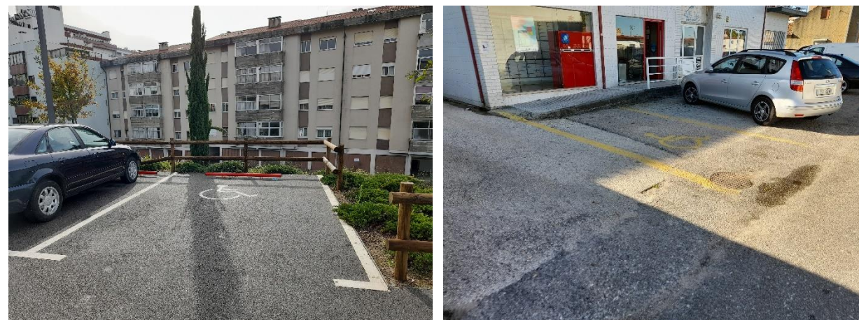
Figura 30. Lugares de estacionamento para pessoas com mobilidade reduzida não regulamentares na área de estudo
