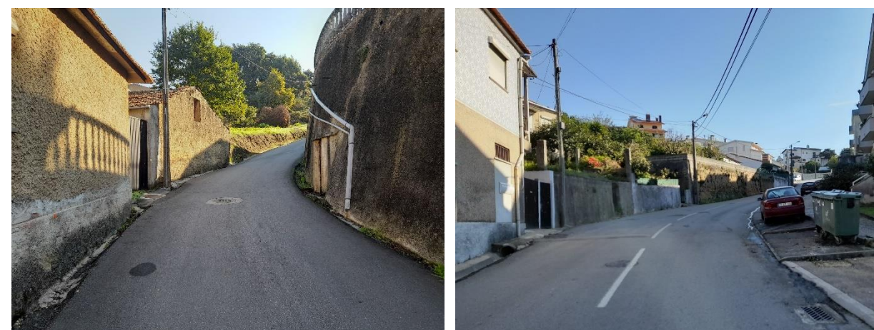
Figura 36. Exemplos de ausência de percurso pedonal Fonte: mpt®, 2021
