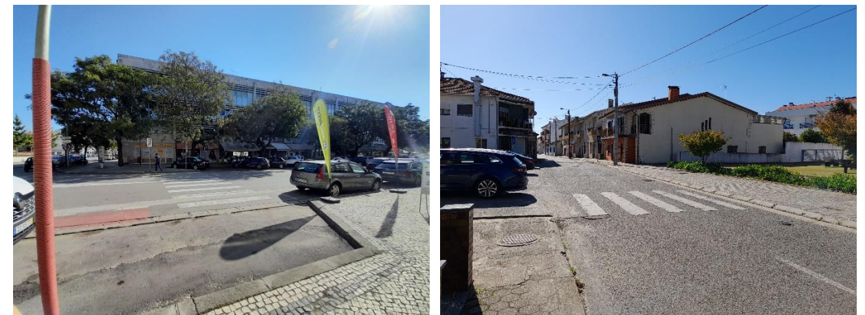
Figura 31. Exemplos de passadeira a terminar em estacionamento Fonte: mpt®, 2021
