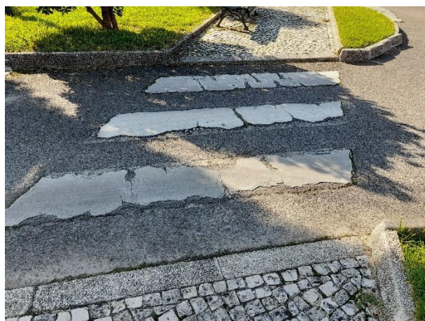
Figura 32. Exemplo de passadeira subdimensionada Fonte: mpt®, 2021
