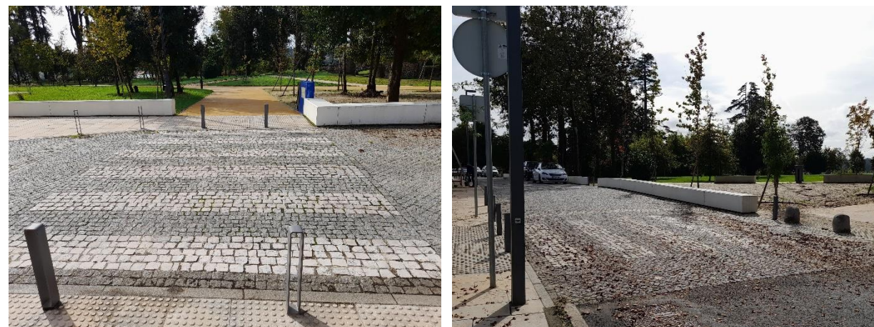
Figura 30. Exemplos de passadeira desconfortável Fonte: mpt®, 2021
