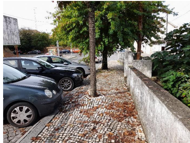
Figura 19. Exemplo de caldeira de árvore a obstruir o percurso pedonal Fonte: mpt®, 2021
