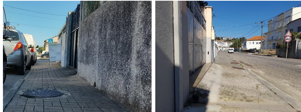
Figura 27. Exemplos de inclinação transversal acentuada Fonte: mpt®, 2021
