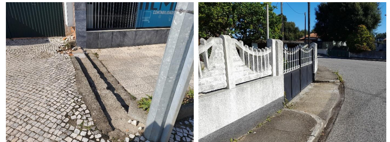
Figura 23. Exemplos de degrau a obstruir o percurso pedonal Fonte: mpt®, 2021
