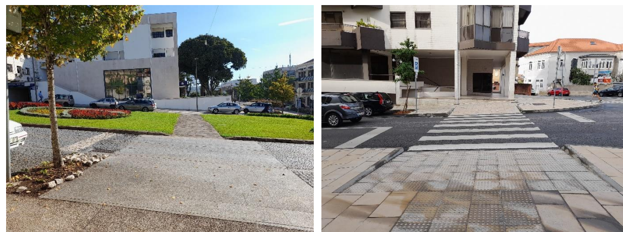
Figura 35. Exemplos de ausência (esq.) e execução indevida (dir.) de pavimentos táteis Fonte: mpt®, 2021
