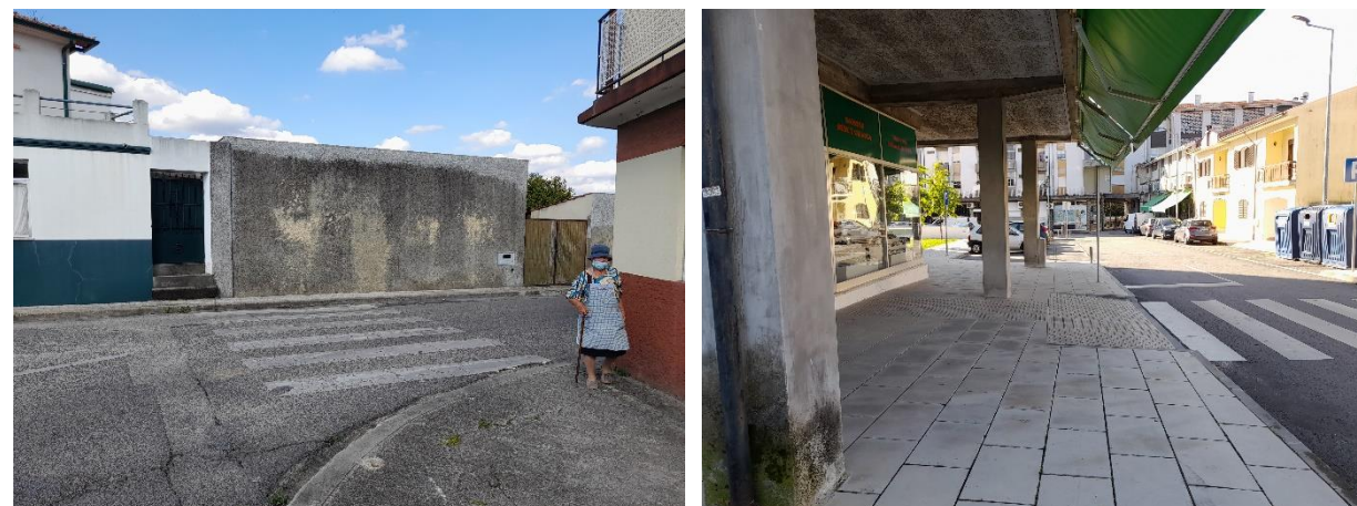
Figura 40. Exemplos de ausência (esquerda) e má execução dos rebaixamentos (direita) Fonte: mpt®, 2021
