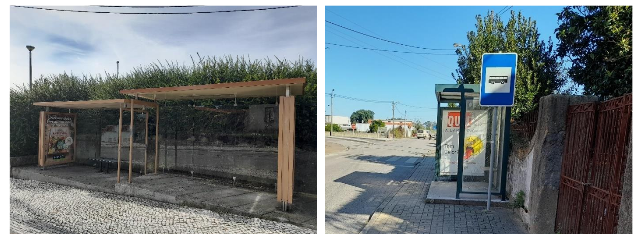
Figura 57. Inexistência de acesso de nível nas infraestruturas de apoio ao transporte coletivo rodoviário Fonte: mpt®, 2021
