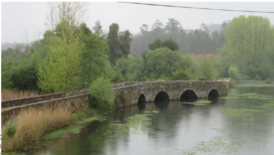
Figura 4 – Ponte Medieval do Marnel, Lamas do Vouga
