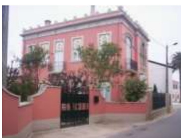
Casa em Aguada de Cima Rua da Azenha (255 / D203)
