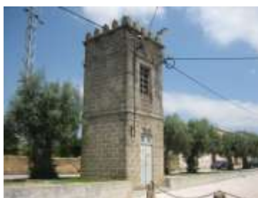
Torre Electricidade – Travassô (390)
