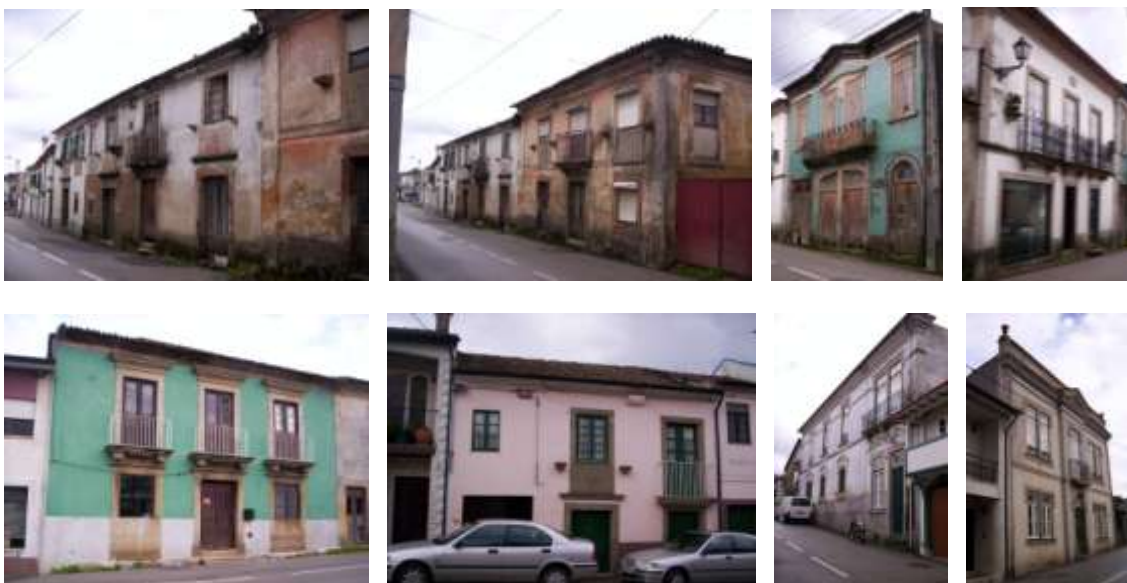
Figuras 107 a 115 – Conjunto de Casas em Arrancada do Vouga (25 a 34 / D276 a D285)
