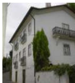
Casa na Borralha Rua Comandante Pinho e Freitas (269 / D214)
