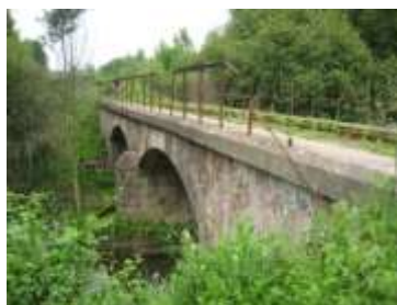
Ponte sobre o Rio Marnel – Lamas do Vouga (429)
