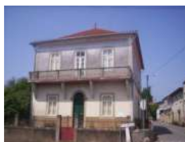
Casa em Aguada de Cima Rua do Outeiro (257)
