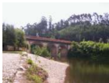
Ponte sobre o Rio Alfusqueiro – Bolfiar (424)
