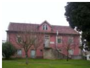
Casa em Valongo do Vouga Praça de São Pedro (303 / D245)
