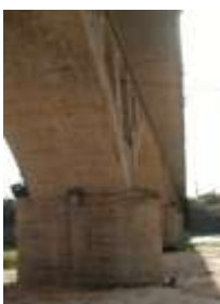
Ponte sobre o Rio Vouga – Sernada (427)
