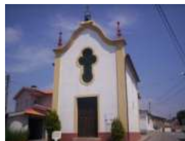
Capela de São Tiago na Borralha Freguesia: Borralha (169 / D120)
