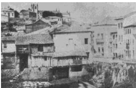
Figuras 118 – Antiga ponte demolida.
