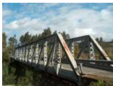
Ponte de ferro sobre o Rio Caima (426)
