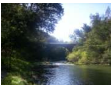
Ponte sobre o Rio Alfusqueiro – Préstimo (425)
