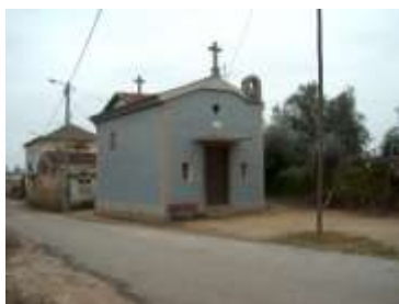
Capela de São Sebastião na Mesa Freguesia: Macinhata do Vouga (189 / D140)
