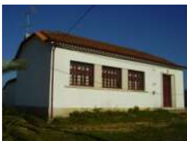
EB1 Bustelo - Aguada de Cima (Desactivada) (219 / D168)
