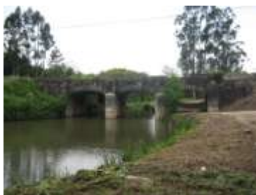
Ponte sobre o Rio Marnel - Lamas do Vouga (428)
