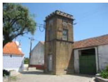
Torre Electricidade - Trofa (391)
