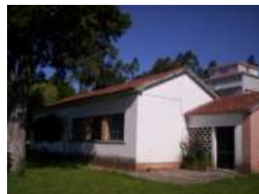
EB1 Bolfiar - Águeda (Desactivada) (221 / D170)
