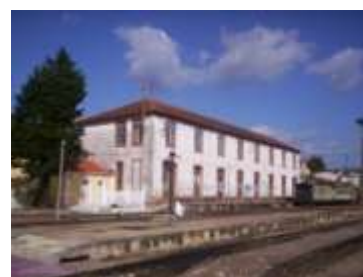
Edifício junto Estação CP Semada do Vouga (247 / D195)
