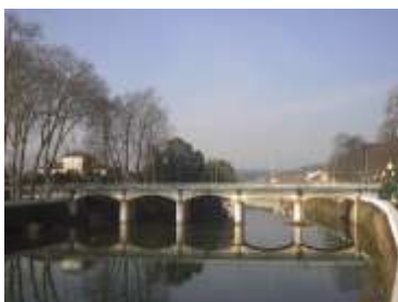
Ponte sobre o Rio Águeda – centro cidade (422)
