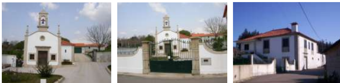
Figura 50 a 52 – Capela do Sobreiro (14 / C10).
