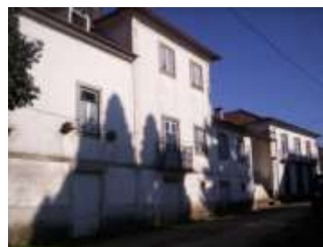
Casa em Valongo do Vouga Rua dos Talhos (328 / D268)
