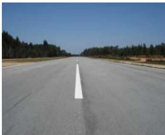
Figura 23 – Vista da Pista do Aeródromo.
