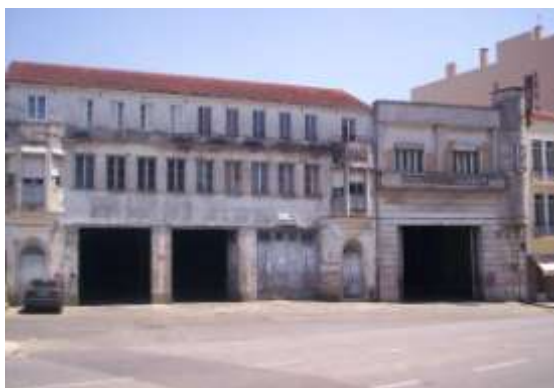
Figura 19.1 – Edifício do Centro de Camionagem.
